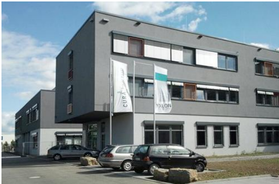
Das neue Applikations- und Dienstleistungszentrum in Heilbronn Bild: Xylon
