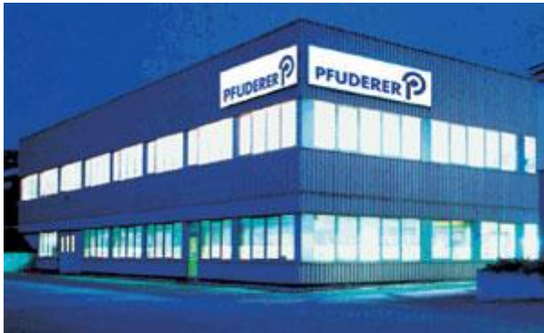
Pfuderer-Firmengebäude in Ludwigsburg (Bild: Pfuderer)
